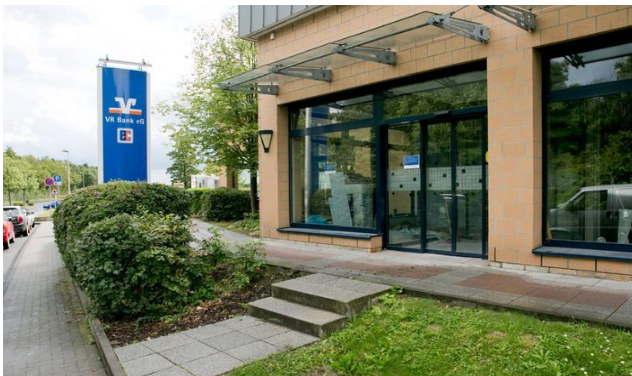
Im SB-Center der VR Bank, das zurzeit noch umgebaut wird, steht den Kunden beider Geldinstitute ab 20. September ein Geldautomat zur Verfügung. Foto: ati
